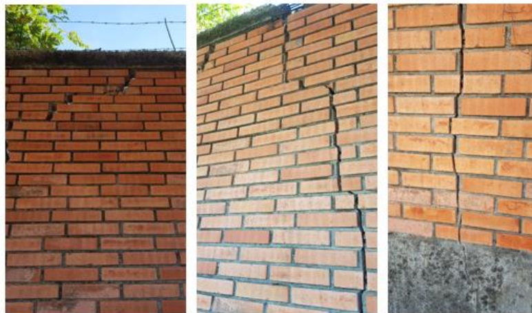
Agrietamientos en muros colindantes Ecopetrol.
